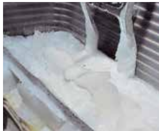
Обмерзання зовнішнього блоку без нагрівання піддону
