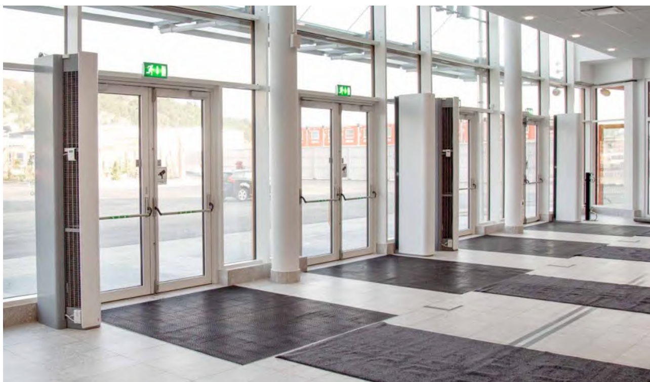
Вертикально расположенные завесы серии Pamir 3500 с декоративным комплектом, который помогает эстетично скрыть трубные подводы и электрические провода.
